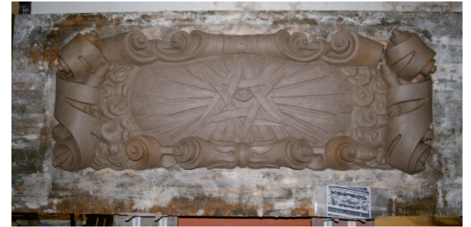
Abb. 5: Triersches Haus. Die Reliefplatte im zweiten Obergeschoss des Erkers. (© Stefan Hertzig, Dresden)
