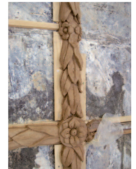
Abb. 7: Triersches Haus. Modellarbeiten für die historischen Fensterkreuze. (© Stefan Hertzig, Dresden)
